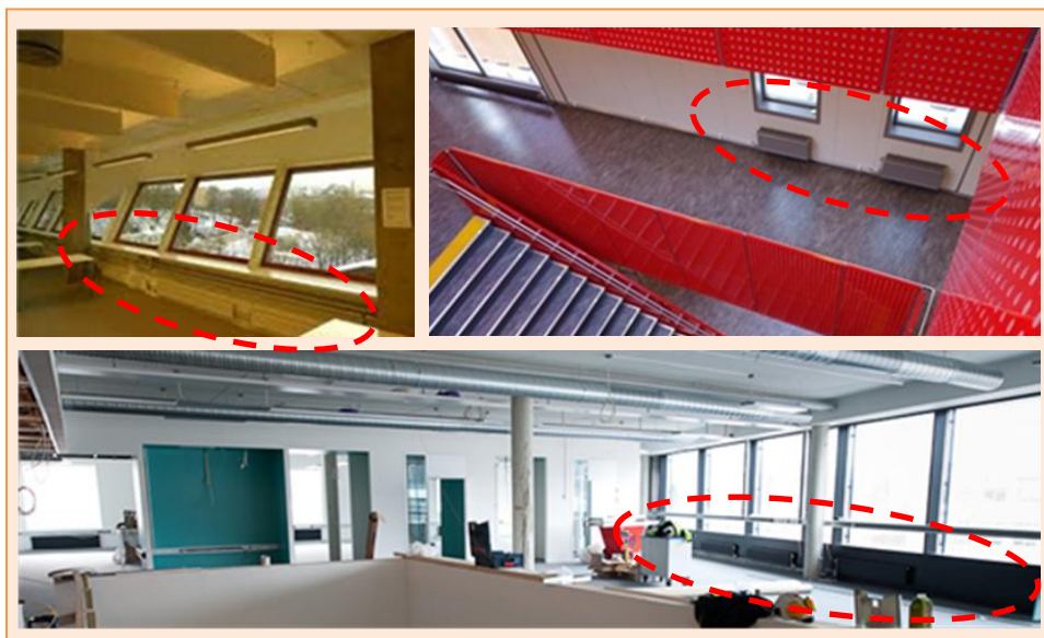
Figur 4 Plassering av varmeelement i tre av Norges mest moderne kontorbygg anno 2012 – Bellonabygget, NSB-kompetansesenter og Papirbredden 2 (passivhus-standard).
